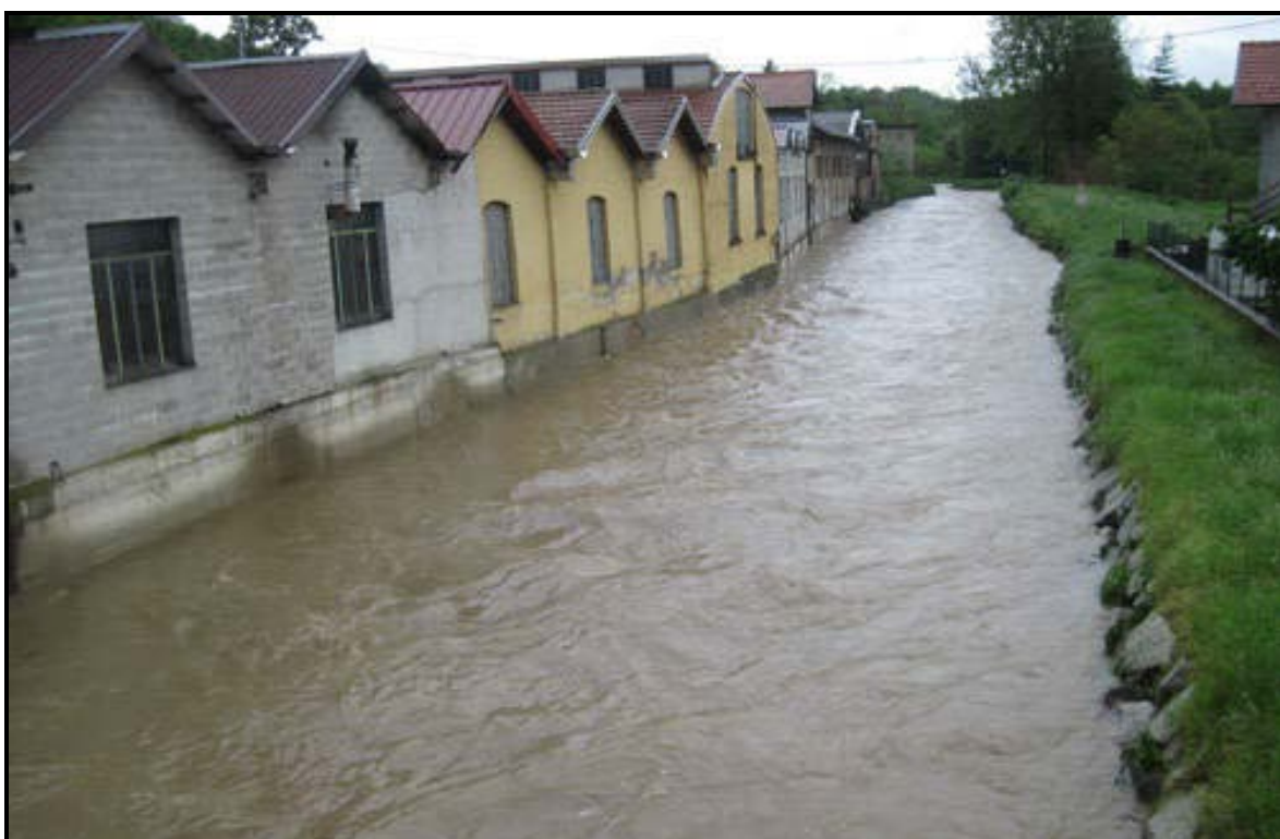
Figura 21: l'area industriale di Torba in sponda destra, ripresa in condizioni di piena ordinaria dal ponte di via Battisti verso monte (maggio 2010 – fonte:www.varesenews.it)
