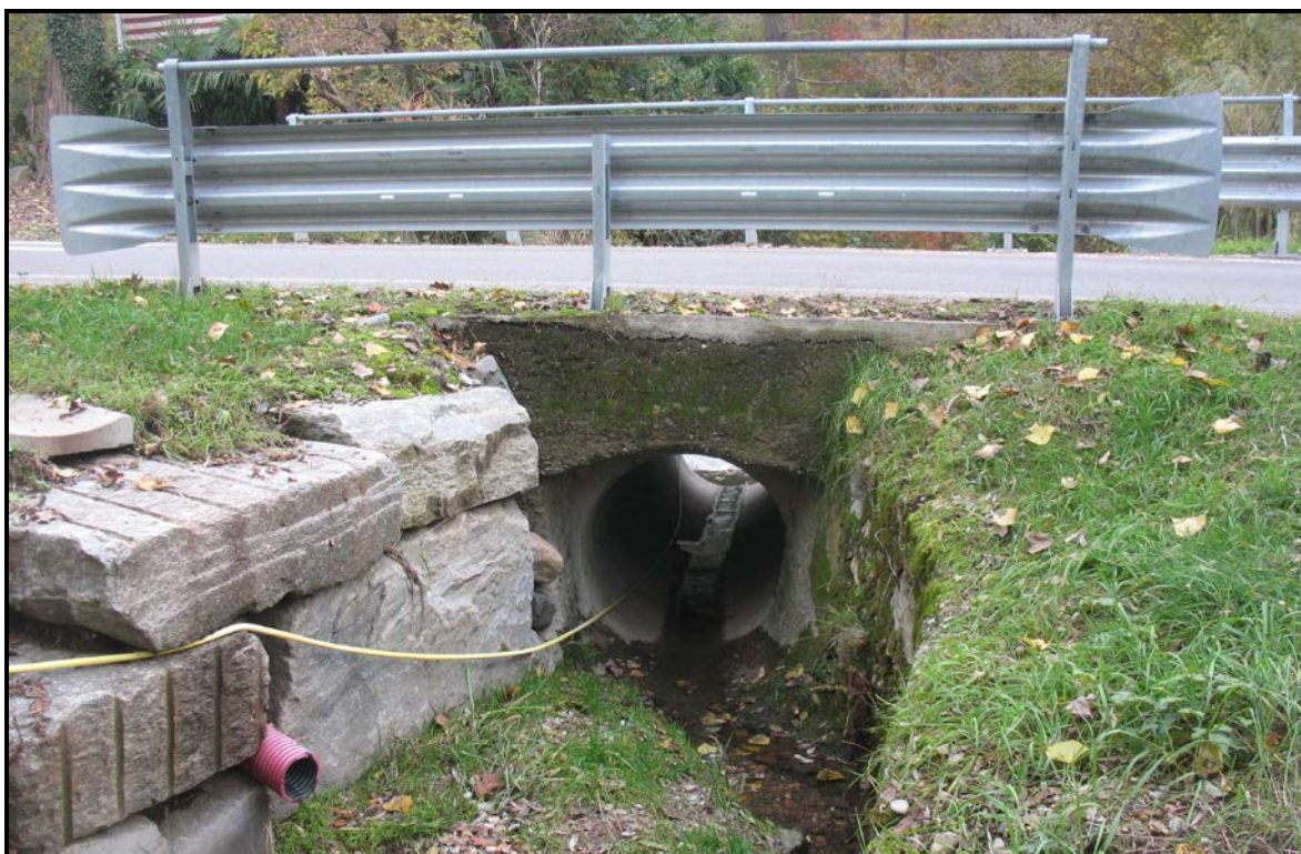
Figura 58: sottopasso del rilevato stradale di via Monte Grappa (condotto in calcestruzzo, f 100 cm)
