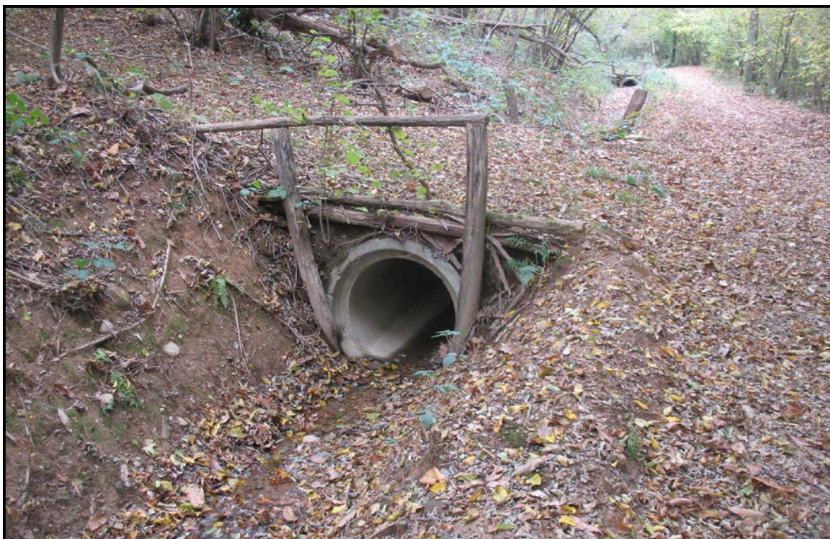
Figura 33: l'imbocco di una delle opere disposte in alveo per garantire l'accesso ai fondi privati
