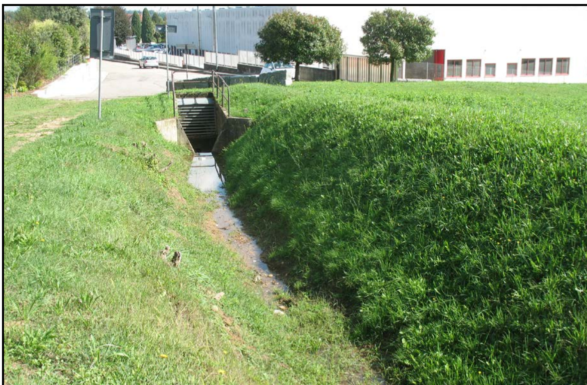
Figura 39: panoramica del manufatto di recapito del corso d'acqua, in direzione di via Campi Aperti
