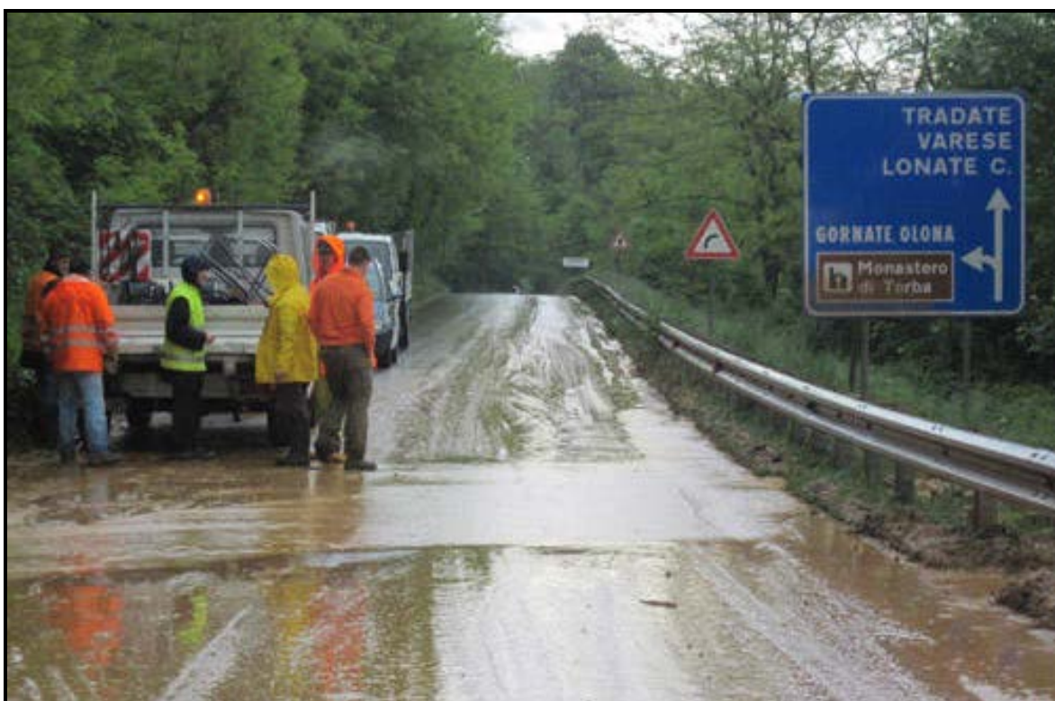
Figura 24: allagamento della sede stradale della S.P. 42 in corrispondenza dell'attraversamento del corpo idrico rubricato al numero 8, in occasione delle piogge occorse nel maggio 2010 (fonte:www.varesenews.it)
