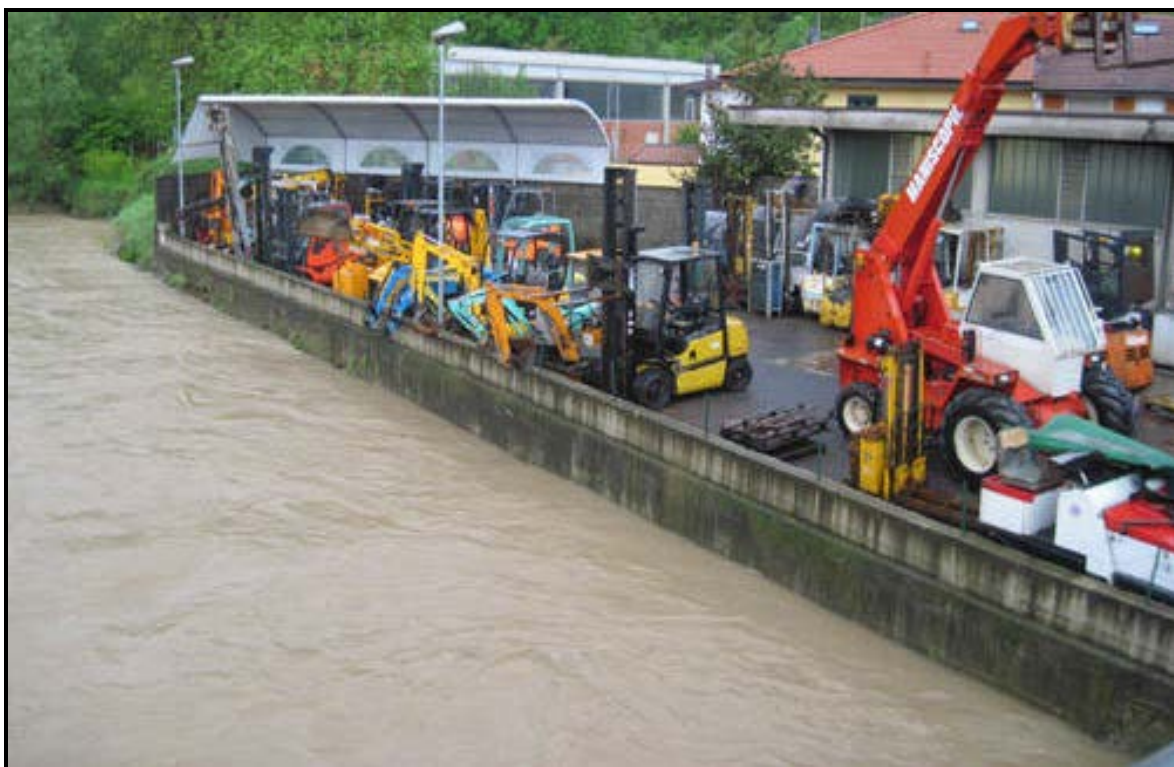
Figura 22: l'area industriale di Torba in sponda destra, ripresa in condizioni di piena ordinaria dal ponte di via Battisti verso valle (maggio 2010 – fonte:www.varesenews.it)
