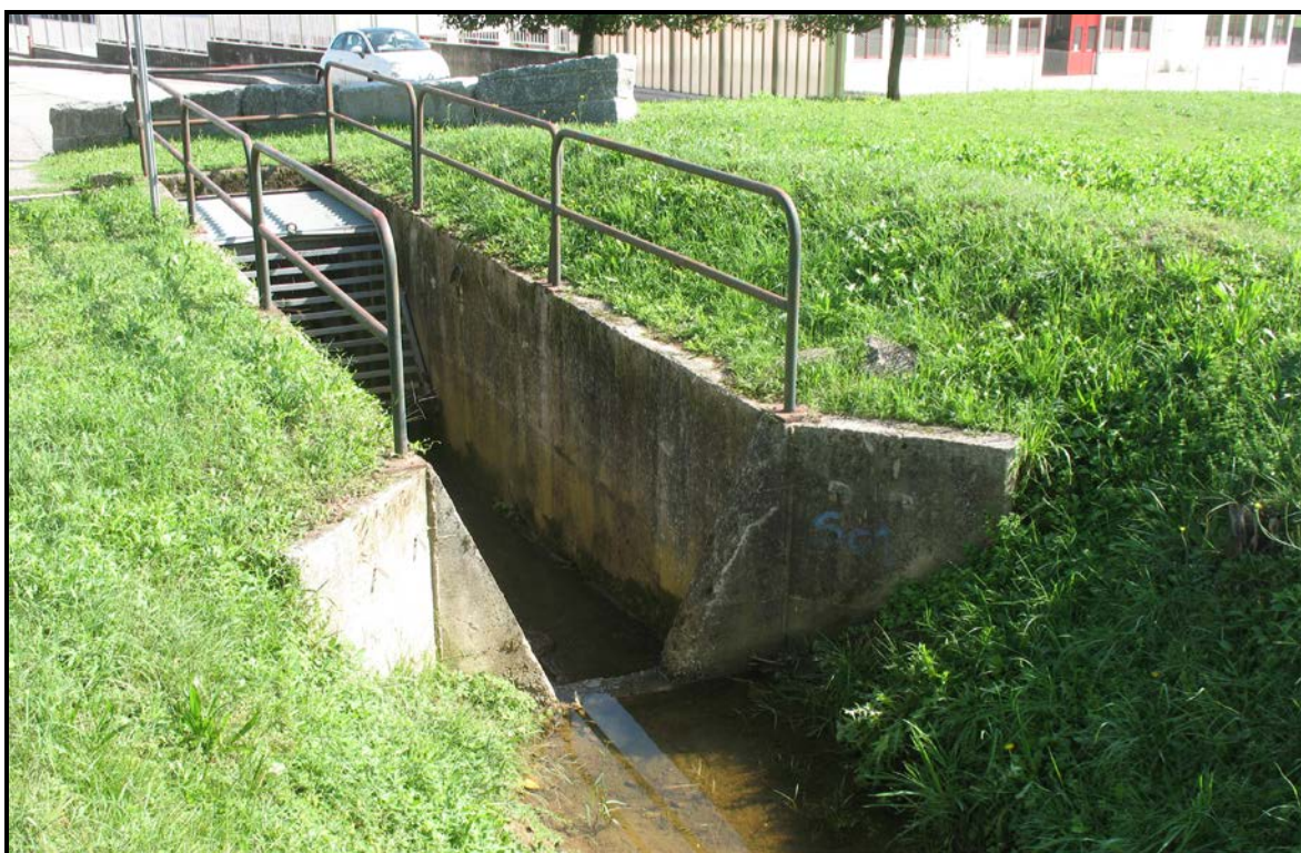
Figura 40: dettaglio del manufatto di recapito, con evidenza della griglia disposta a protezione dell'imbocco, e del rilevato arginale esistente verso destra, realizzato anche con impiego di massi ciclopici
