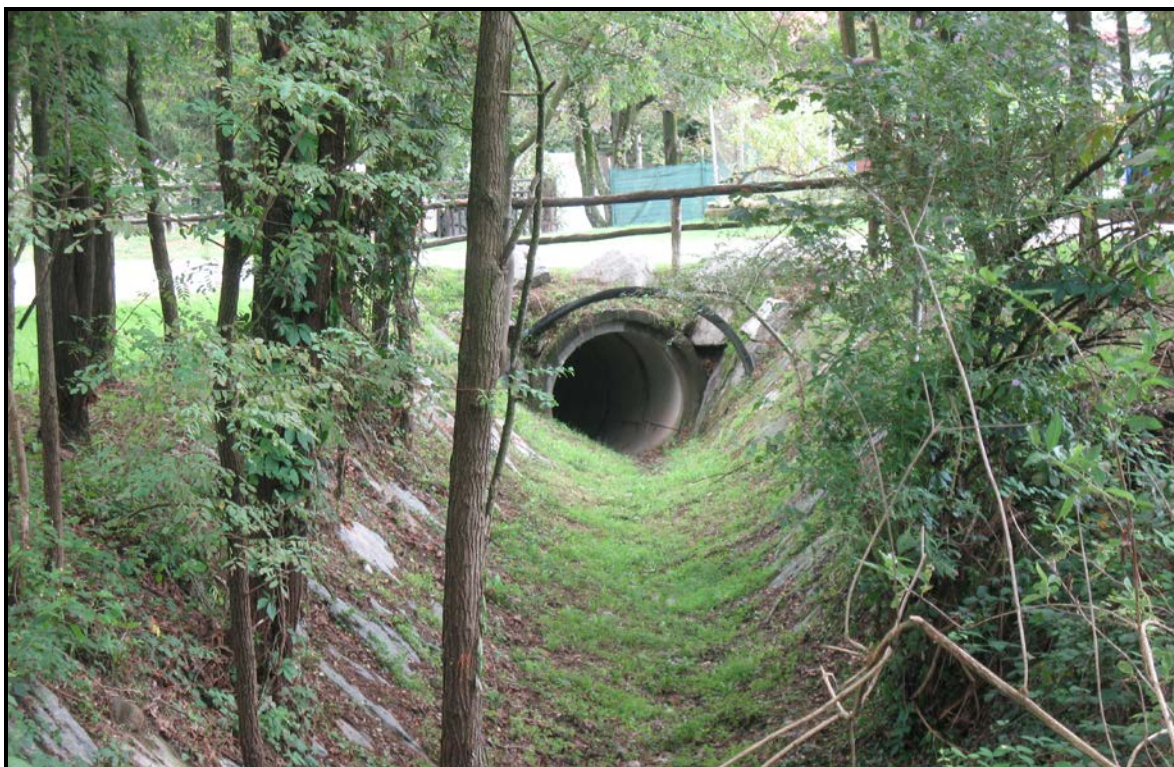
Figura 55: condotta f 180 cm in calcestruzzo, in corrispondenza dell'accesso ad un'area industriale, vista da monte
