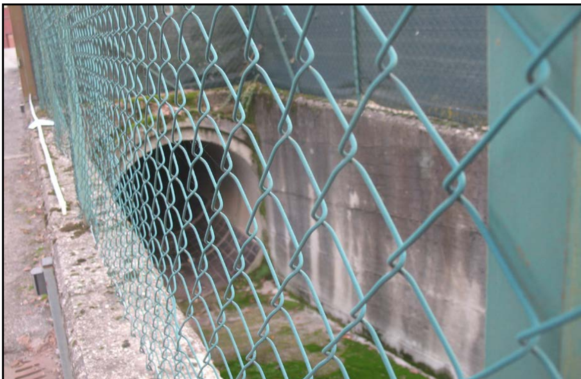
Figura 56: la sezione di imbocco della tombinatura terminale, a monte di via Battisti (condotta f 180 cm in calcestruzzo)
