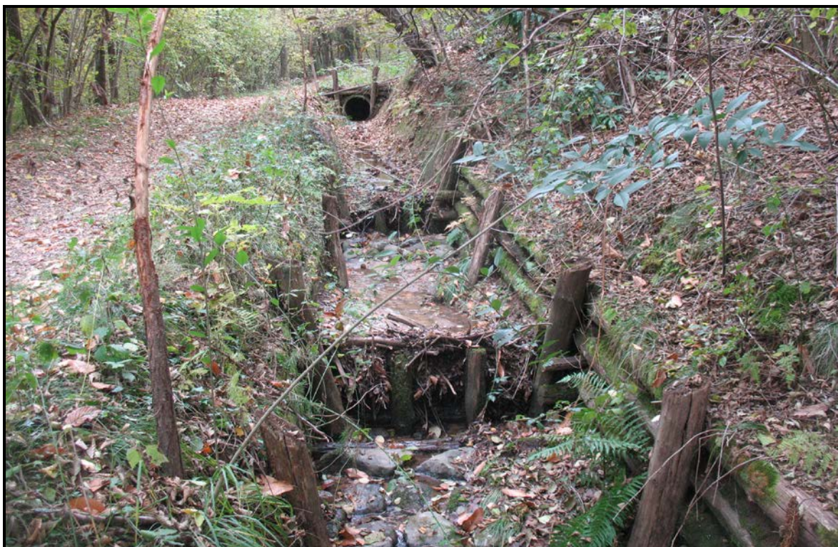
Figura 35: opere di consolidamento delle sponde, in un tratto di alveo in fregio alla strada
