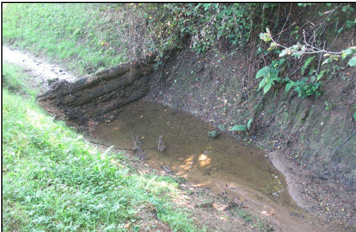
Figura 41: particolare relativo allo sbarramento, ed al relativo bacino di calma, disposto ai piedi del pendio, a monte del manufatto
