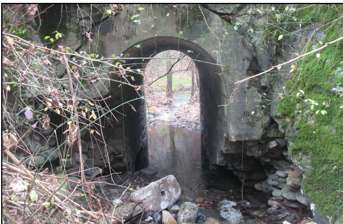
Figura 31: ripresa del sottopasso della pista ciclopedonale, da monte
