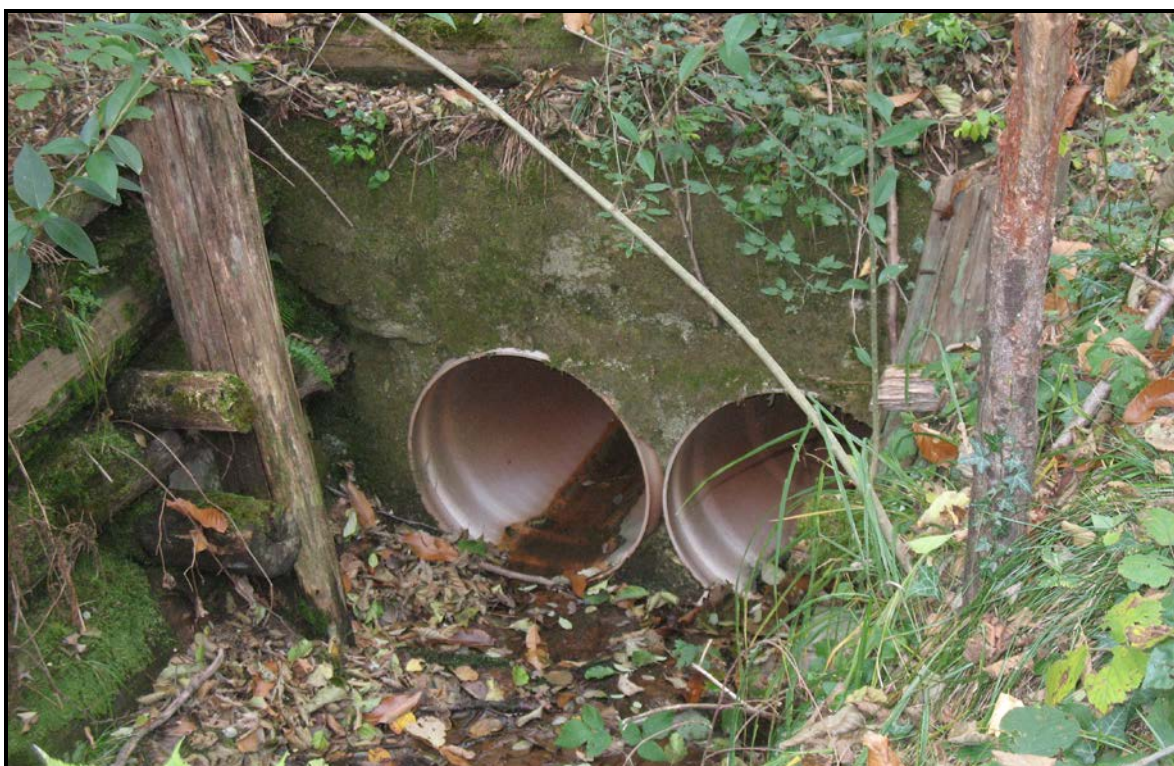
Figura 36: l'imbocco della tombinatura di attraversamento della pista che costeggia l'alveo
