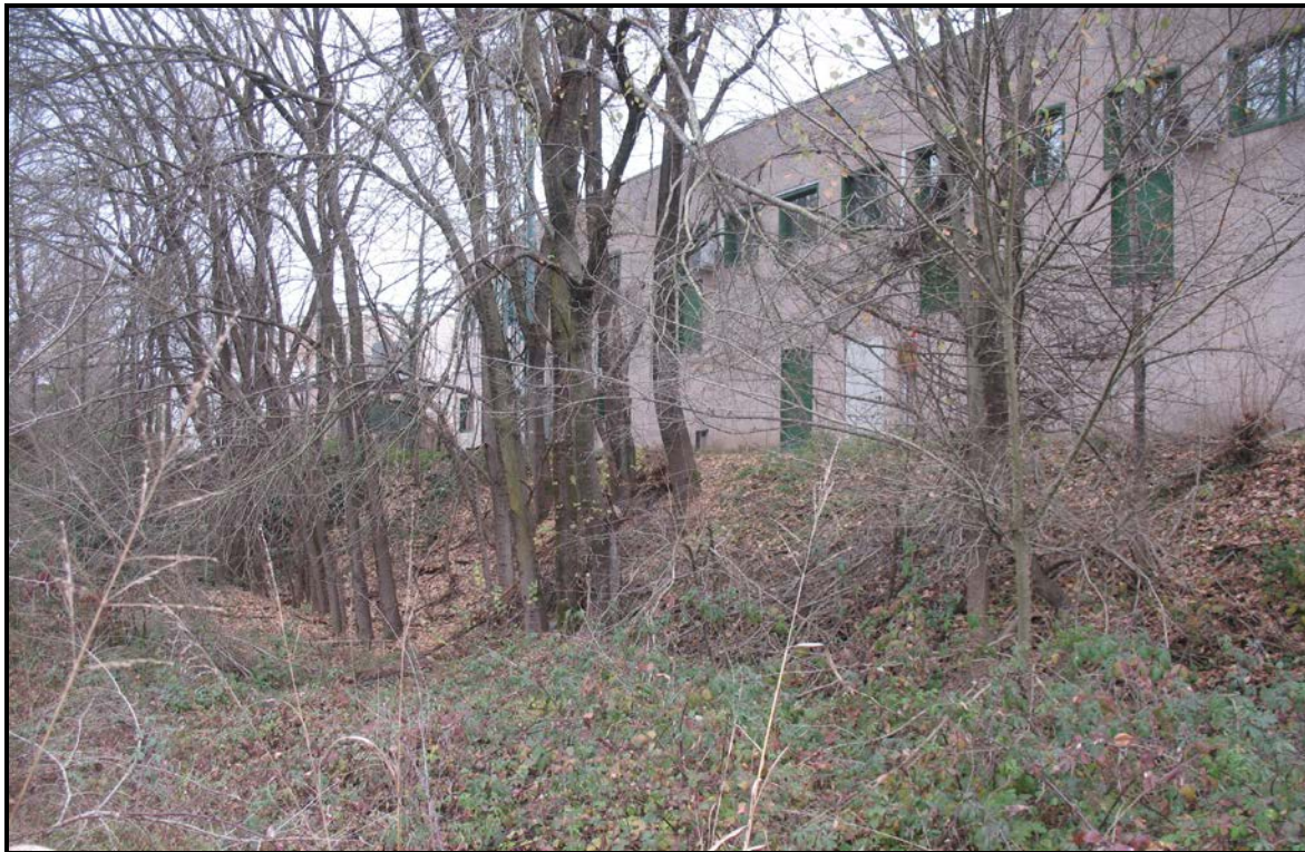
Figura 29: dettaglio della scarpata che delimita, verso monte, l'area individuata dal calcolo come soggetta ad allagamenti con cadenza "frequente" (pericolosità P3/H)
