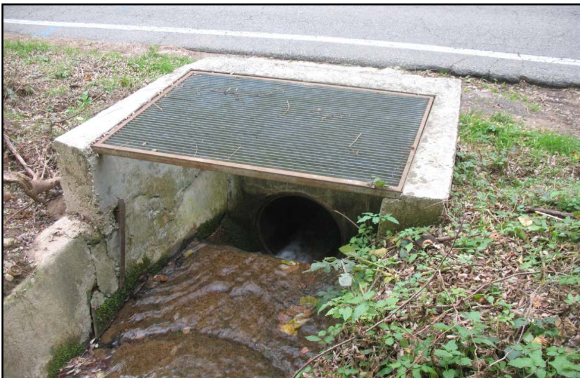
Figura 50: dettaglio del manufatto di imbocco, con evidenza della griglia di protezione e della sezione iniziale del condotto, di diametro pari a 60 cm
