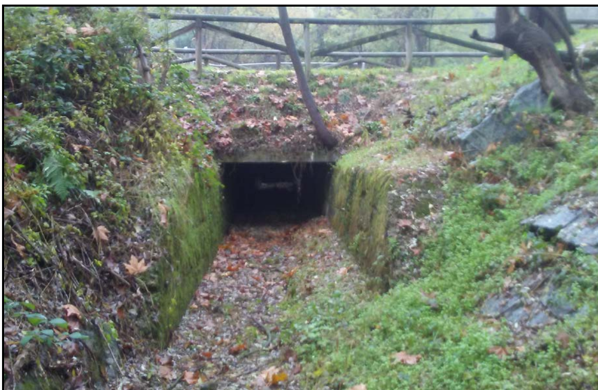
Figura 54: il sottopasso della pista ciclopedonale dell'Olona, visto da valle
