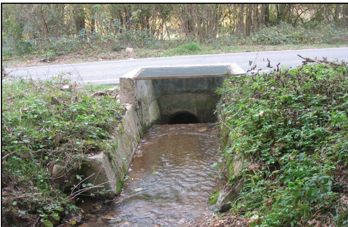
Figura 49: panoramica della sezione di imbocco della tombinatura di attraversamento di via primo Maggio
