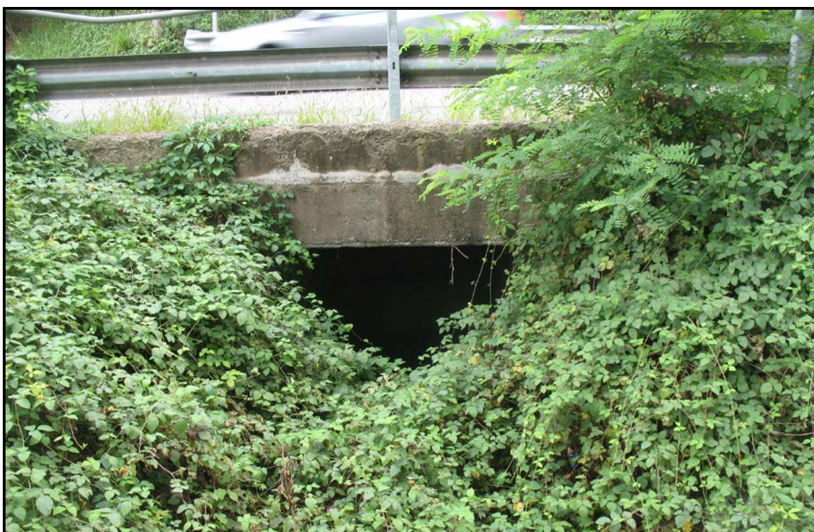
Figura 53: dettaglio relativo al cunicolo di sottopasso della S.P. 42, visto da valle
