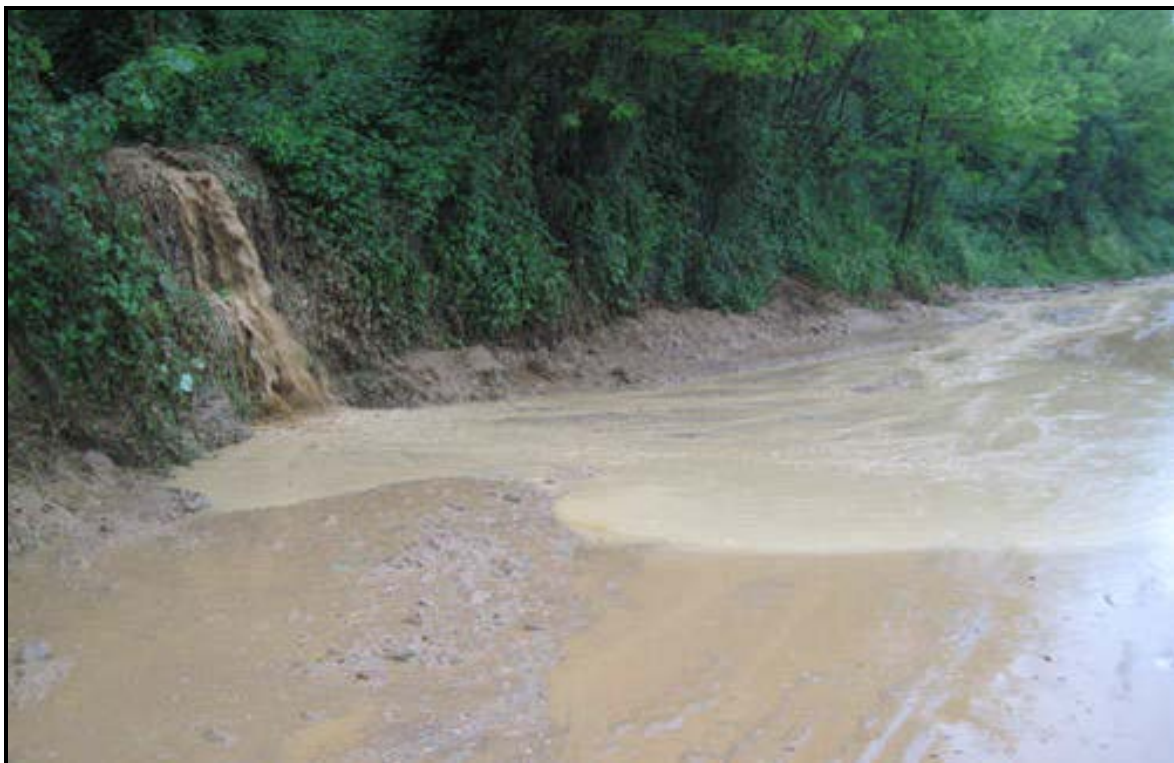
Figura 26: allagamento della sede stradale della S.P. 42, fra Torba e Castelseprio, in corrispondenza dell'attraversamento del corpo idrico rubricato al numero 8, in occasione delle piogge occorse nel maggio 2010 (fonte:www.varesenews.it)
