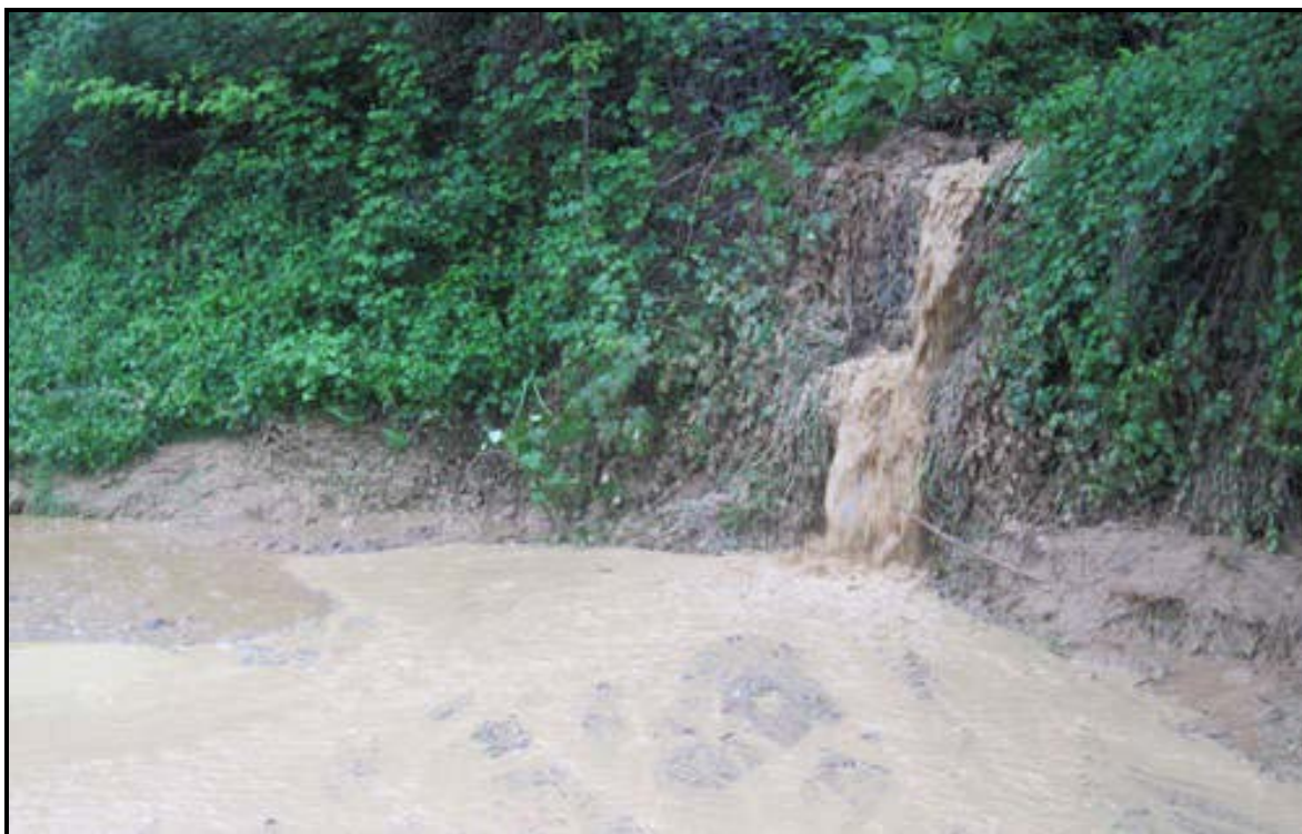
Figura 25: allagamento della sede stradale della S.P. 42, fra Torba e Castelseprio, in corrispondenza dell'attraversamento del corpo idrico rubricato al numero 8, in occasione delle piogge occorse nel maggio 2010 (fonte:www.varesenews.it)
