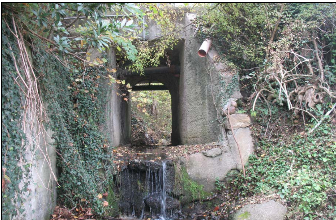
Figura 30: il sottopasso della S.P. 42 (via Cadorna), visto da valle
